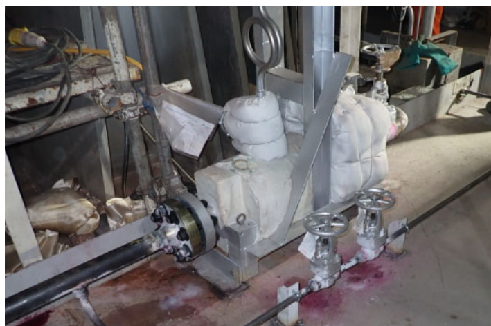
通过追加Hot Standby功能而追加设置的蒸汽导入线和排水线
