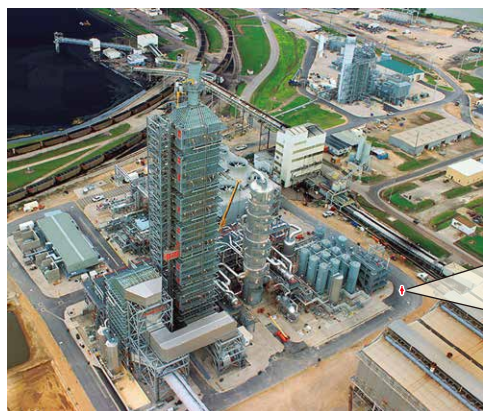
世界最大規模CO 2 回収プラント (回収量:4,776トン/日)
