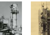
1971 イラク向けNo.1肥料プラント引渡し
