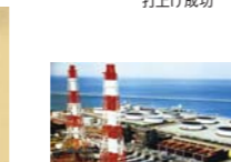
1985 世界最大級コンバインド発電プラント「東北電力、東新潟3号機第二系列545,000kW」完成
