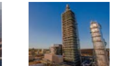
2009 「北海道電力泊発電所3号機」商業運転開始
