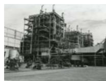
1968 国産初の50万kW超臨界圧ボイラ「中部電力知多3号機1,700t/h」完成
