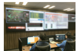
環境設備のAI遠隔監視・運転支援システムMaiDAS ®
