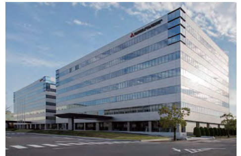
本社ビル(広島)
