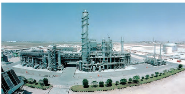
メタノールプラント
