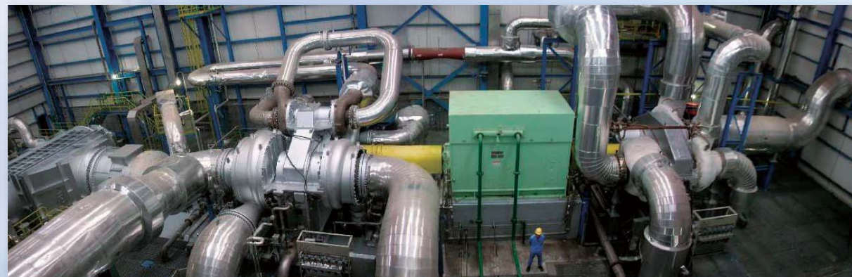
Воздушный компрессор (шестиступенчатый) и газовый экспандер для завода по производству очищенной терефталевой кислоты
