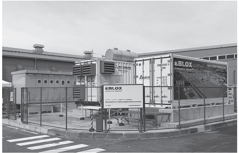
写真-1 相模原工場内のトリプルハイブリッド自立給電システム「EBLOX」
