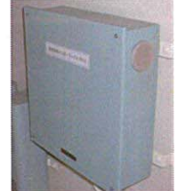
インターフェースボックス外部信号とのやり取りを行います。(居住区設置)
