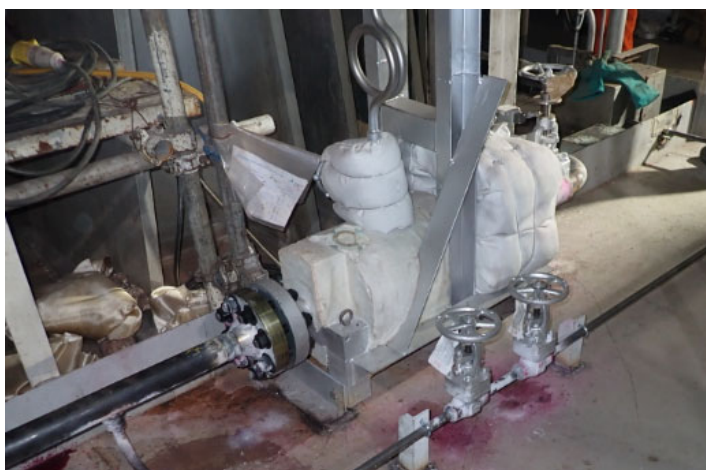
Hot Standby機能追加により追設された蒸気導入ラインとドレンライン
