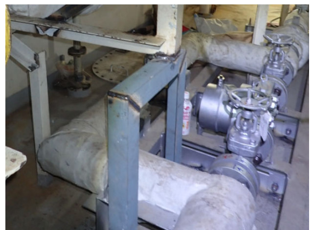
Hot Standby機能追加により追設された蒸気導入ラインとドレンライン
