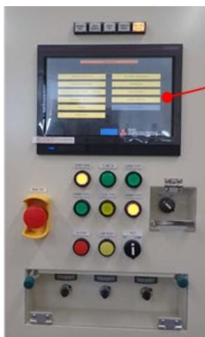
制御装置換装後操作盤
