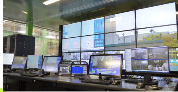
複数エリアの監視装置を光回線、無線伝送装置でネットワーク接続し統合運用可能な多機能監視システム
