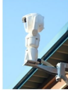
高感度・望遠カメラの死角をカバーする高感度の小型旋回カメラ
