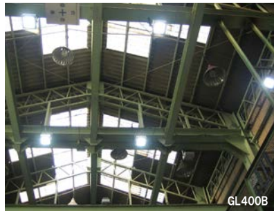
工場天井照明
