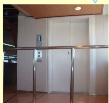
閉鎖区画居住区(防火扉)
