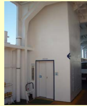
車両区画エレベータケーシング
