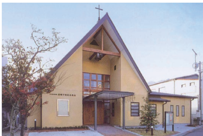
日本基督教団 長崎平和記念教会 構造：木造 階数：地上2階建 延べ面積：410㎡ 竣工：1999年
