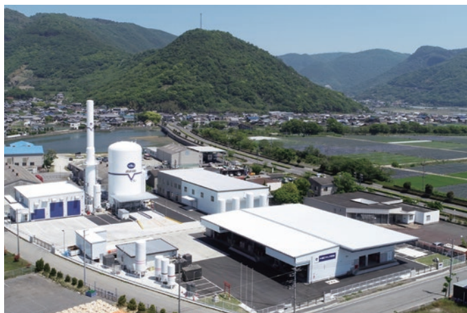
エア・ウォーター西日本株式会社 香川工場、讃岐液酸VSU工場 構造：S造 階数：地上1階建 延べ面積：3,371㎡ 竣工：2020年
