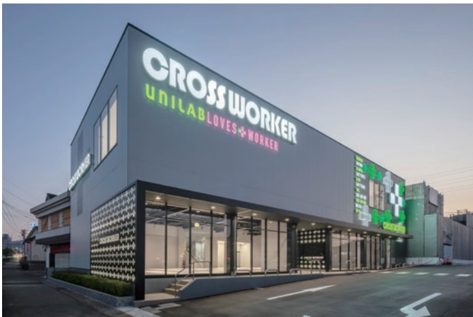
クロスワーカー諫早インターチェンジ店 構造：S造 階数：地上2階建 延べ面積：874㎡ 竣工：2020年
