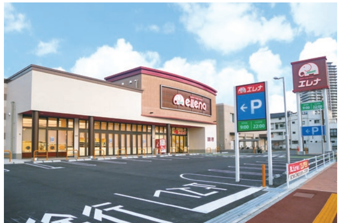
エレナ 稲佐店 構造：S造 階数：地上2階建 延べ面積：1,771㎡ 竣工：2019年
