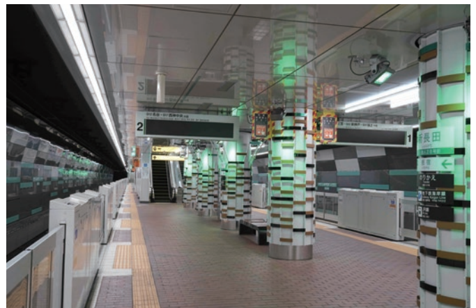
ホーム改修工事
