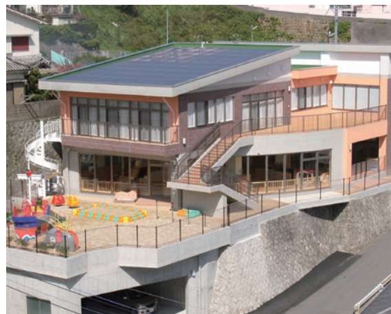
キラキッズ保育園 構造：S造 階数：地上2階建 延べ面積：685㎡ 竣工：2010年
