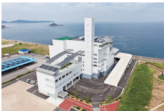
長崎市西工場(ごみ焼却場) 構造：SRC造 階数：8階 延べ面積：13,982㎡ 竣工：2016年
