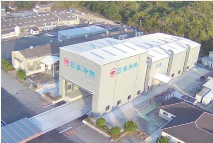
日本冷熱天草工場 A棟新築工事
