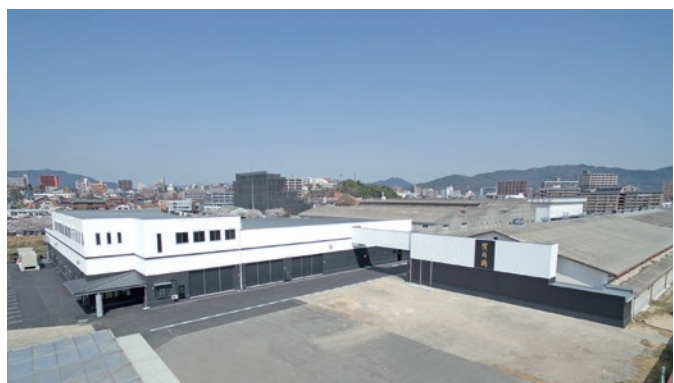
賀茂鶴酒造株式会社 御園蔵新瓶詰工場 構造：S造 階数：地上2階建 延べ面積：4,925㎡ 竣工：2018年
