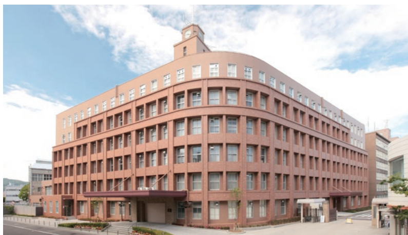
三菱重工業株式会社 神戸造船所 本館耐震補強工事
