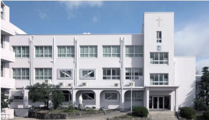
愛徳学園 中学校・高等学校耐震補強工事 構造:RC造 階数:地上3階建 延べ面積:872㎡ 竣工:2016年
