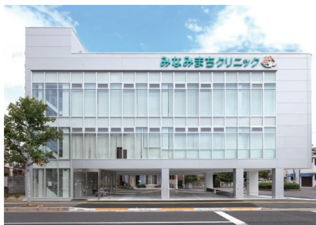
みなみまちクリニック 構造：S造 階数：地上3階建 延べ面積：727㎡ 竣工：2013年
