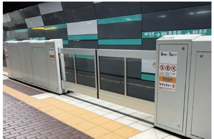
神戸市交通局 ホームドア整備事業 竣工：2024年
