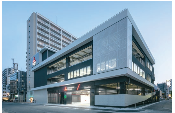
九州三菱自動車販売株式会社 薬院店サービス工場 構造：S造 階数：地上4階建 延べ面積：3,121㎡ 竣工：2021年
