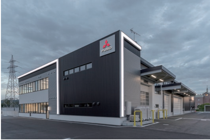
三菱ふそうトラック・バス株式会社 東北ふそう仙台支店 大河原サービスセンター 構造：S造 階数：地上2階建 延べ面積：1,807㎡ 竣工：2022年
