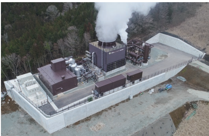
小国町おこしエネルギー地熱発電所設置工事 地熱発電設備工事の内、発電エリアの機械基礎工事 工事内容:地熱発電(シングルフラッシュ方式)4990kW 竣工:2024年
