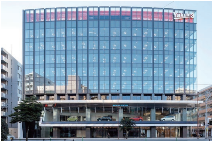
九州三菱自動車販売株式会社 KMGビル (Yakuin3) 構造：S造 階数：地上8階建 延べ面積：10,400㎡ 竣工：2021年
