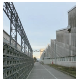
アウトフレーム 耐震工事前
