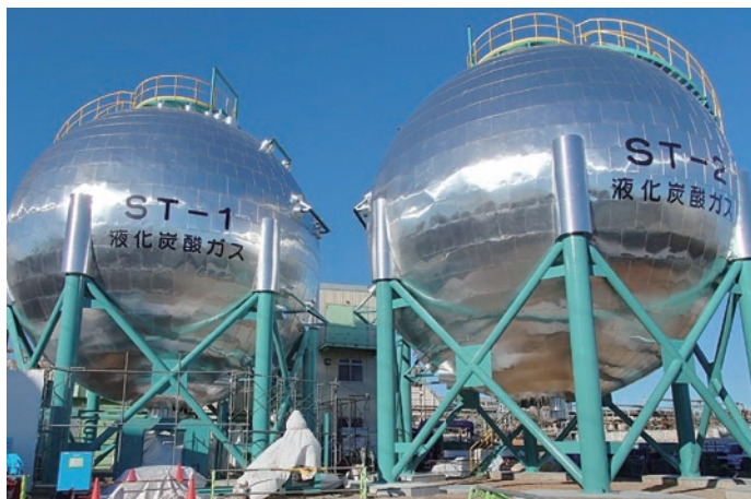
株式会社レゾナック・ガスプロダクツ 液化炭酸ガス球形貯蔵槽建設工事 タンク容量：1,000ton × 2基 竣工：2024年
