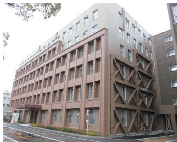
鉄骨外付ブレース
