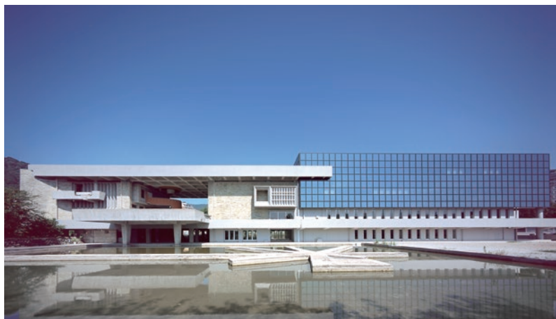
長崎総合科学大学 人間環境学部校舎 構造：SRC造 階数：地上4階建 延べ面積：4,992㎡ 竣工：2002年
