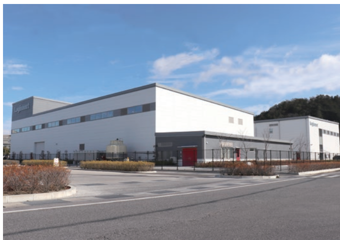
三菱ロジスネクスト株式会社 滋賀工場 試験棟、事務棟、試験走行路他 試験棟 構造：S造 階数：地上1階建 延べ面積：2,052㎡ 竣工：2020年 事務棟 構造：S造 階数：地上2階建 延べ面積：2,291㎡ 竣工：2020年
