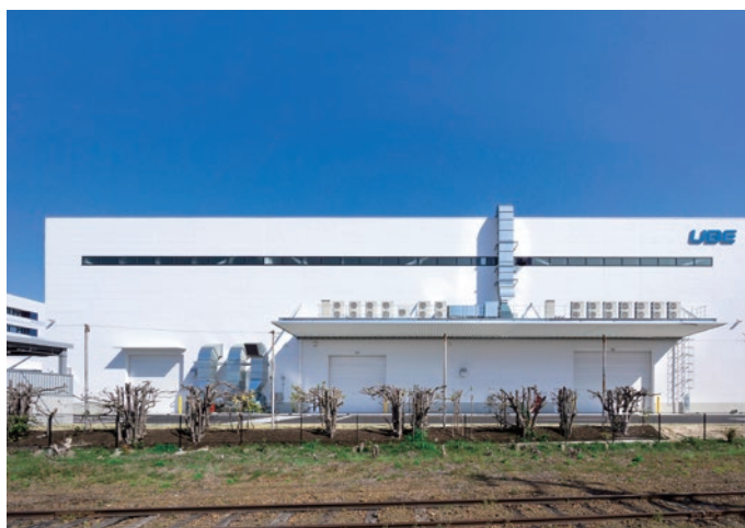
UBEマシナリー株式会社 名古屋事業所 構造：S造 階数：地上2階建 竣工：2020年
