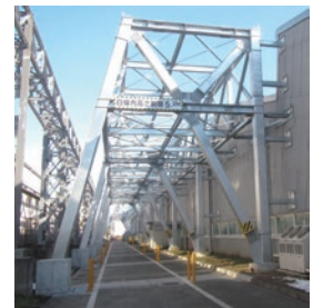
アウトフレーム 耐震工事後
