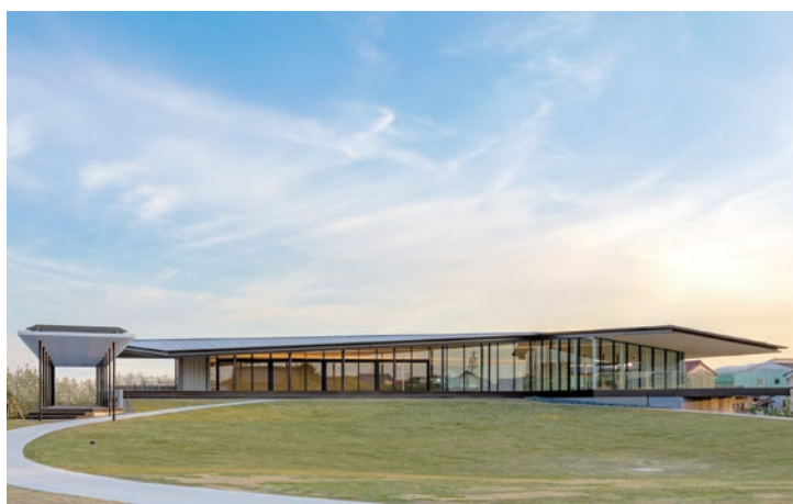
アイコクアルファ株式会社 発祥の地再開発事業 『いこいの広場』 構造：S造 階数：地上2階建 延べ面積：796㎡ 竣工：2021年
