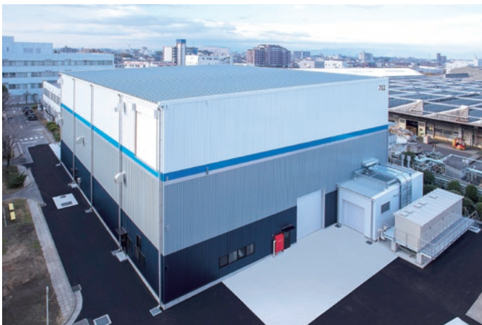
三菱重工サーマルシステムズ株式会社 702試験棟
