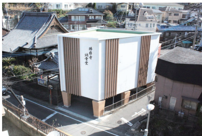
真宗大谷派勝廓寺 納骨堂 構造：RC造 階数：地上3階建 延べ面積：246㎡ 竣工：2017年
