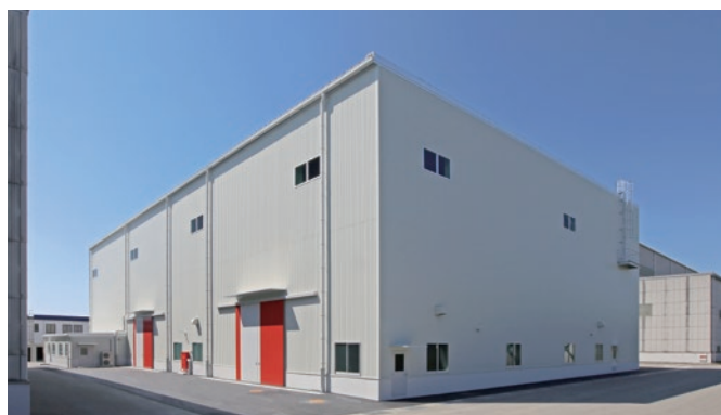
株式会社ジャパンエンジンコーポレーション 倉庫棟 構造：S造 階数：地上1階建 延べ面積：3,901㎡ 竣工：2020年
