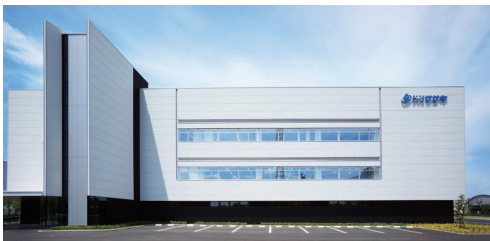
株式会社テックササキ 大江工場 構造：S造 階数：地上3階建 延べ面積：9,178㎡ 竣工：2017年
