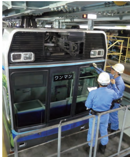
モノレール車両点検
