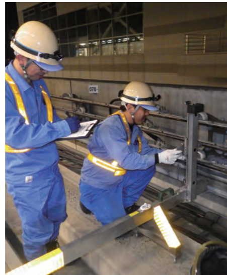
新交通軌道設備保守点検
