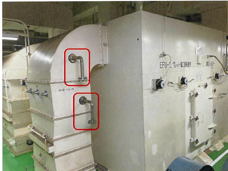
新規制基準適合工事にてルート変更を実施したダストモニタ用配管が残置
