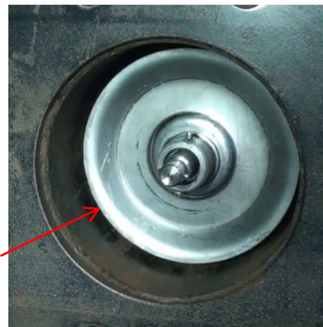
遮へいプラグ取付状況
