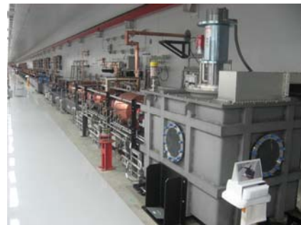
図10：入射部据付状況
