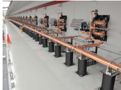
図9：パルス圧縮器据付状況
