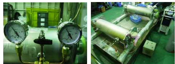
図 9：空洞ジャケット化後の高圧ガス保安協会立会い検査の様子
